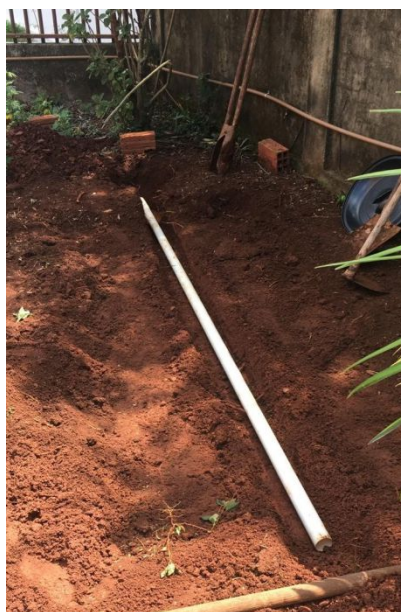
Figura 2: Fundação e Escavação. Fonte: Autor do Trabalho.
