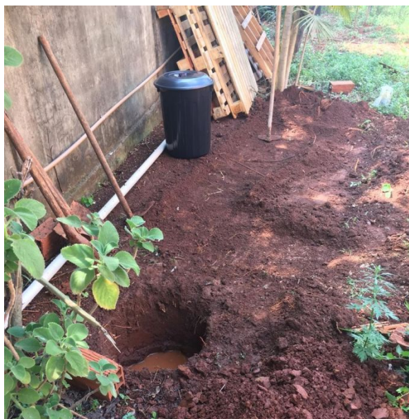
Figura 3: Escavação. Fonte: Autor do Trabalho.
