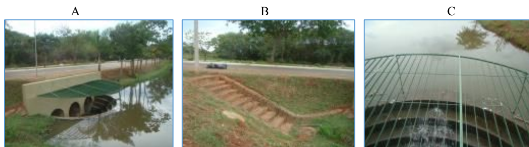
Fig. 07 - Vertedouro (A e C) e escada de dissipação de energia de águas pluviais (B) visando conter os processos erosivos e o bloqueio da entrada de resíduos no lago do Parque Carmo Bernardes, 2019.
