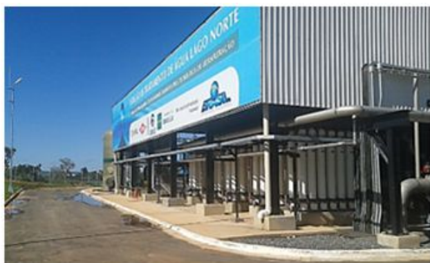
Fachada da Estação de Tratamento de Água do Lago Norte.
