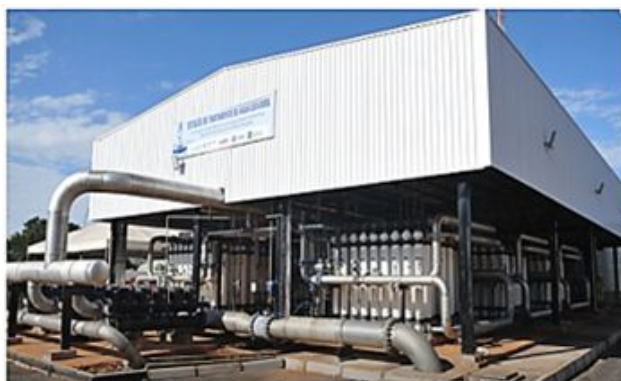
Fachada da Estação de Tratamento de Água do Gama.
