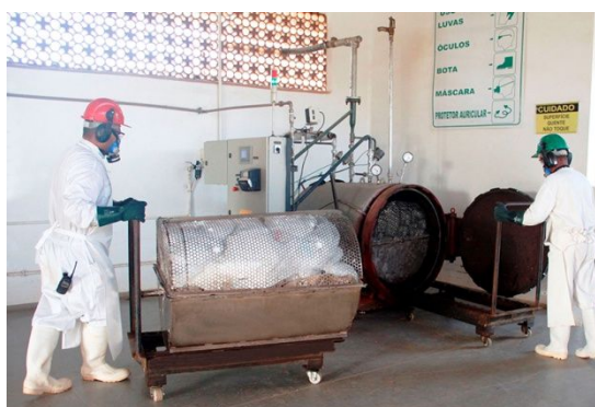
Figura 5. Unidade de Autoclave em Macaé do Centro de Tratamento de Resíduos.
