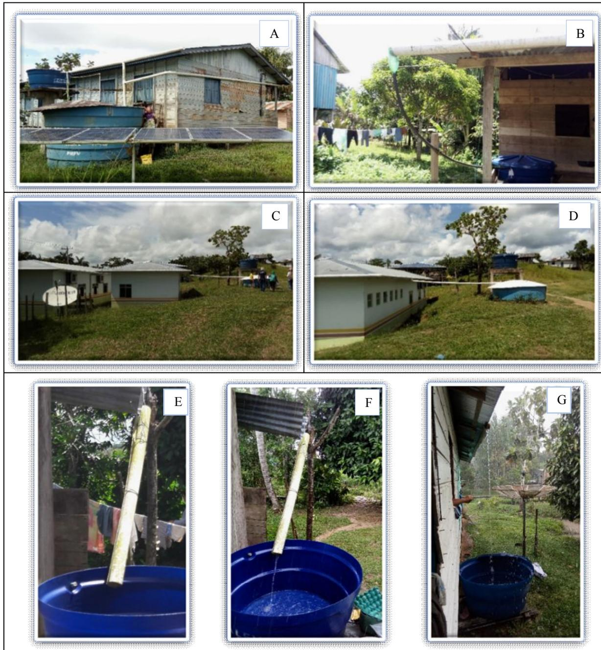
**Figura 2:** Fotografias destacando a captação de água da chuva na comunidade Nova Aliança, Benjamin Constant, AM. (A) local de captação de uso coletivo, com bombeamento e uso de energia solar; (B), (E), (F), (G) captação da água da chuva nas residências dos moradores; (C) e (D) captação da água da chuva na escola da comunidade. **Fonte:** Autora do trabalho (2017).
