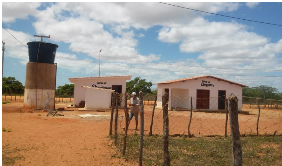
Figura 4: Projeto de retirada de água por poço artesiano com dessalinizador instalado no projeto do assentamento Serra do Mel. Fonte: Autor do Trabalho.
