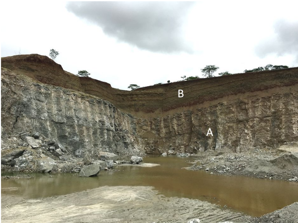
Figura 6: Vista de frente de lavra da Mineração QUALIMINA mostrando: A) Corpo mineralizado de gipsita; B) Capeamento de argilominerais
