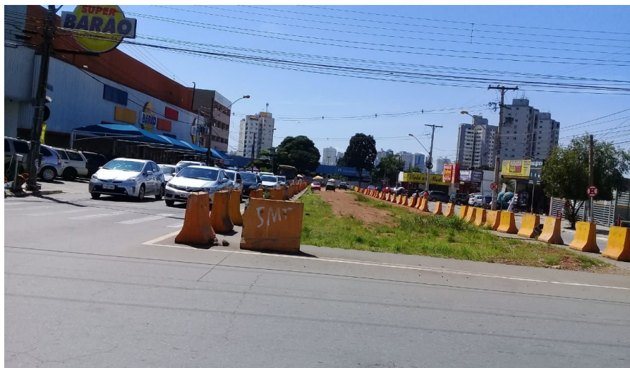
Figura 2 - Obras do BRT em frente ao atual Terminal Isidória (Setor. Pedro Ludovico).
