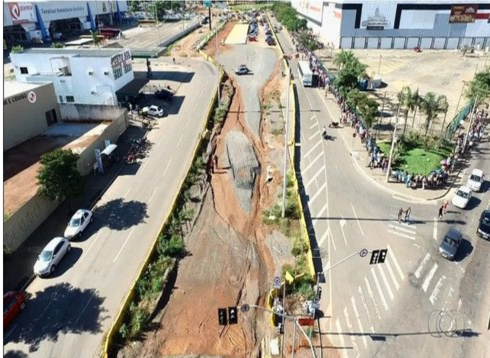
Figura 1 – Vista Aérea de parte da obra do BRT em Goiânia GO.
