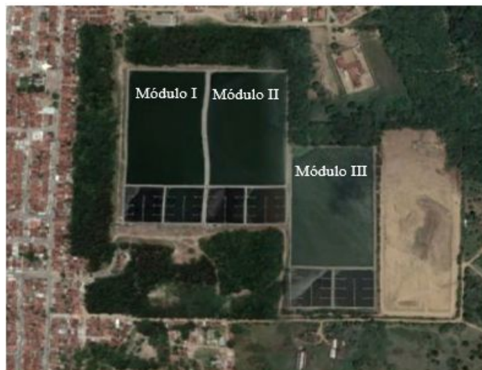
Figura 1. Estação de Tratamento de Esgoto Mangabeira, localizada em João Pessoa (PB). Fonte: Autores do Trabalho.
