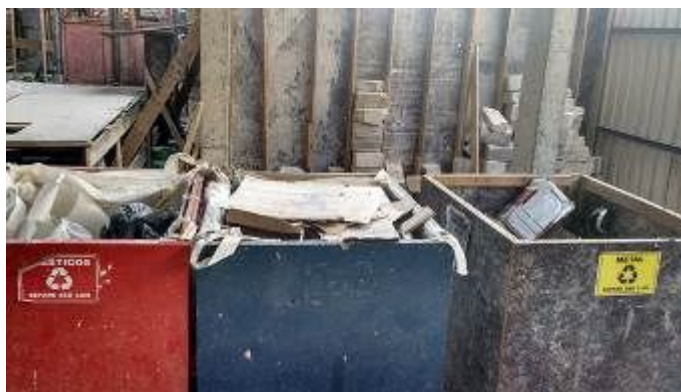
Figura 4 – Acondicionamento de resíduos classe B
