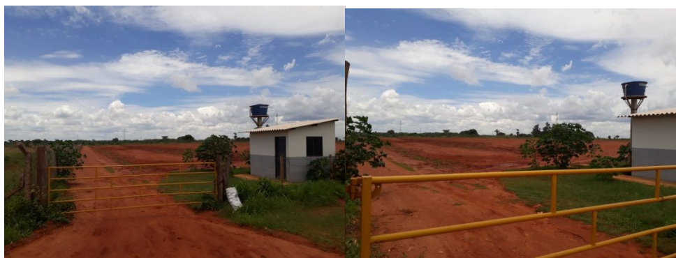
Figura 2 - Terreno da pequena usina de processamento de resíduos de construção civil. Fonte: O Autor, 2018.
