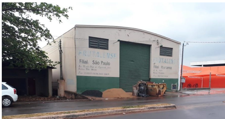
Figura 3 - Alocação de materiais agregados de modo incorreto na Av. José de Alencar. Fonte: O Autor, 2018.
