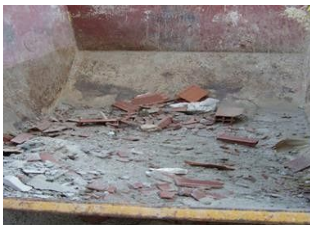
Figura 5 - Caçamba estacionária para acondicionamento final de resíduos. Fonte: Os autores (2019).
