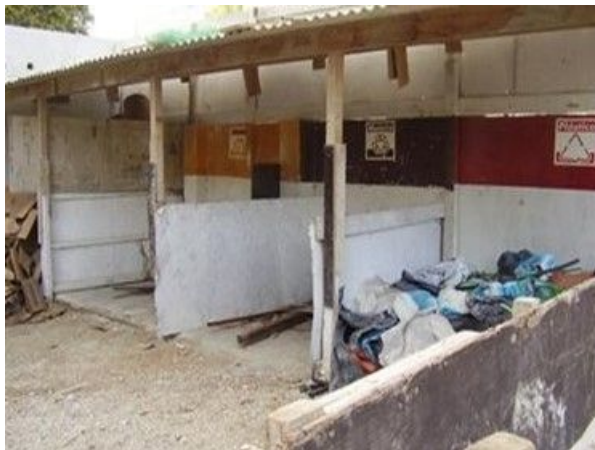
Figura 4 - Baias fixas para acondicionamento final dos resíduos. Fonte: Os autores (2019).
