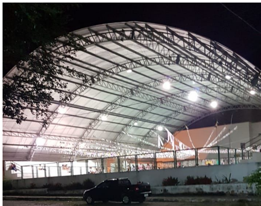
Figura 1: Local em que o evento foi realizado. Fonte: Autor do trabalho
