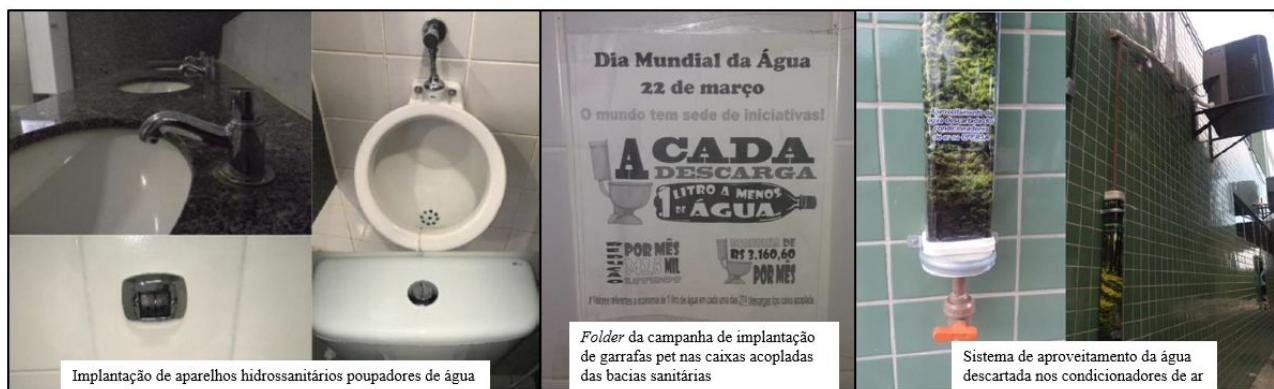
Figura 2: Exemplos de ações de uso racional da água implementadas na Universidade Federal Rural do Semi-Árido. Fonte: Vale (2019); PLS (2013).
