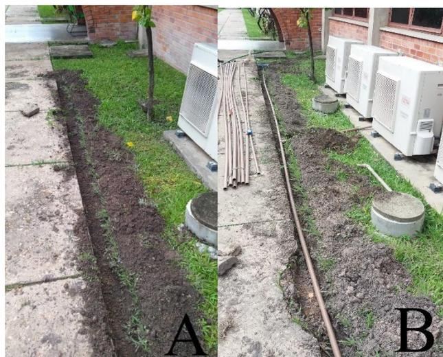
**Figura 2: Escavações para passagem da tubulação (A) - Passagem dos canos (B). Fonte: Sistema de Captação de Água Proveniente dos Ares-Condicionados IFPI (2017).**
