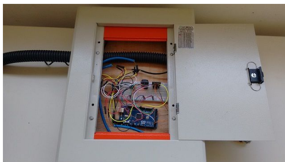
Figura 8 - Conexão final dos sensores ao arduino. Fonte: Própria.
