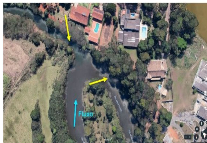
Figura 4 – Ponto 2. Detalhe da erosão e disposição de sedimentos junto à margem esquerda, confluência do Ribeirão João Leite.
