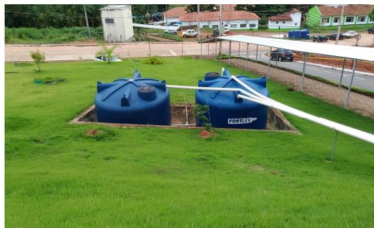
Figura 8: Captação de água pluvial Fonte: Torre, M.R.G.D
