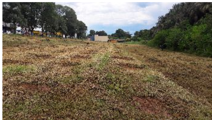
Fig. 03 – preparação da Área para Plantio.
