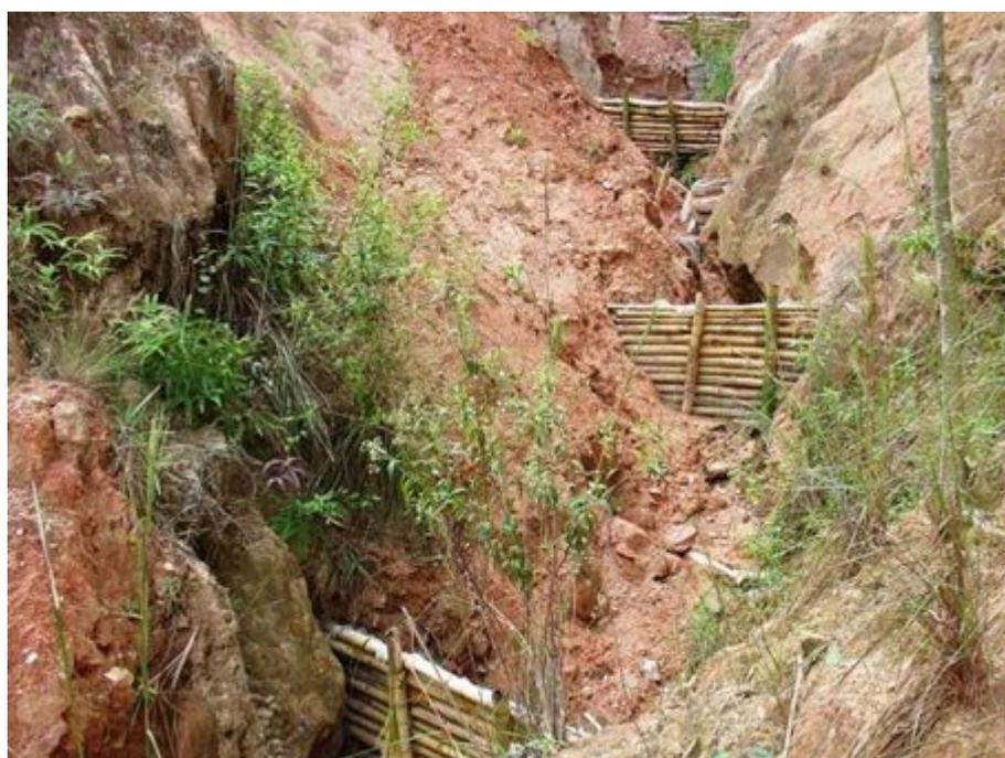
Figura 4: Paliçada de bambu em voçoroca. Fonte: Embrapa, 2015.
