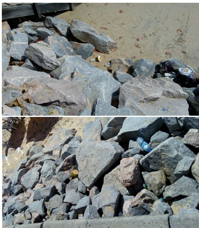
Figura 2: Acúmulo de resíduos entre as rochas encontradas no calçadão como forma de conter a erosão costeira.
