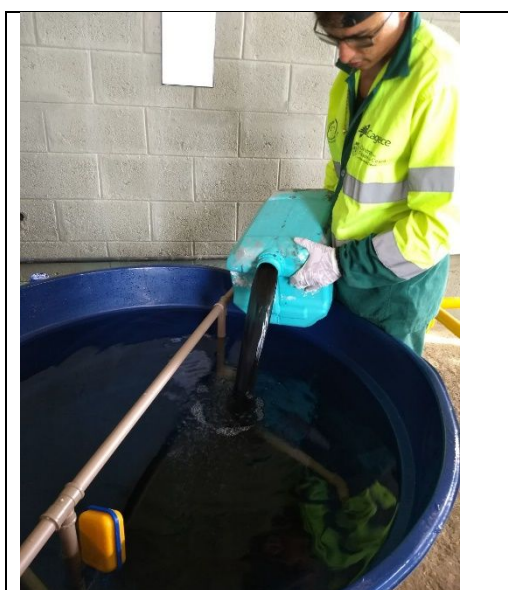
Figura 2 – Preparação da solução biorremediadora na EEE;
