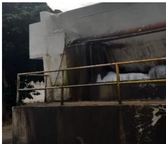
Figura 7: Redução considerável da produção de espuma no efluente após a aplicação do Biopolímero. Data: 16/05/18.
