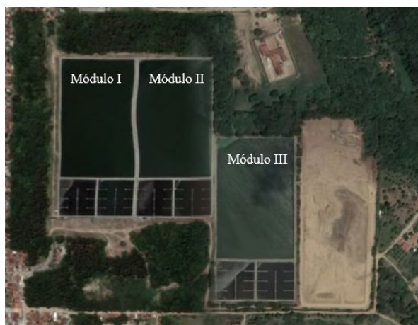
Figura 1: Estação de Tratamento de Efluente Mangabeira em João Pessoa (Paraíba).
