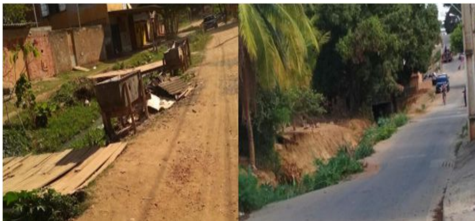
Figura 04: Condição Estrutural e Ambiental do bairro Jardim Atalaia. Fonte: Autores do Trabalho
