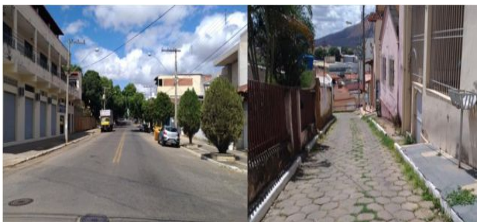
Figura 05: Condição Estrutural e Ambiental do bairro de Lourdes. Fonte: Autores do Trabalho
