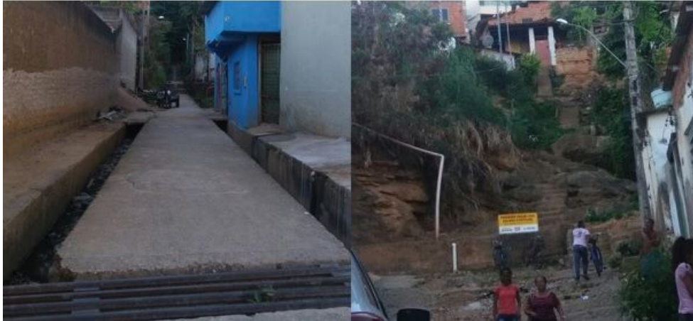
Figura 02: Condição Estrutural e Ambiental do bairro Carapina. Fonte: Autores do Trabalho
