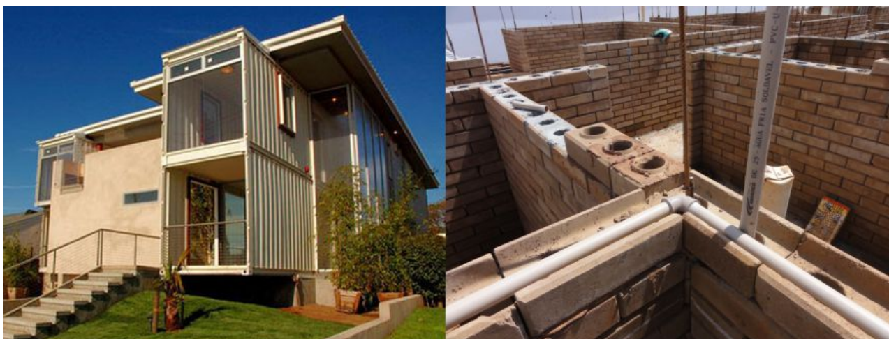
Figura 3: (a) Contêineres como sistema construtivo. (b) Alvenaria modular. Fonte: Portal Metálica Construção Civil (2018); Cia de Arquitetura (2015).
