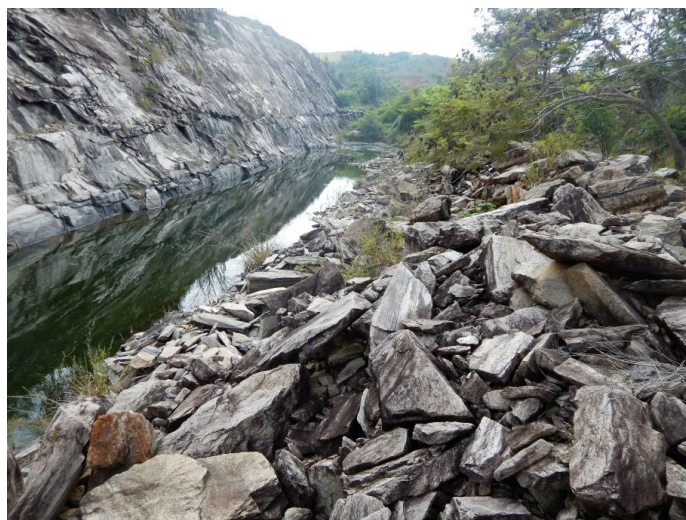
Figura 1: Local de extração degradado e abandonado após encerramento da atividade. Fonte: Autor do Trabalho.
