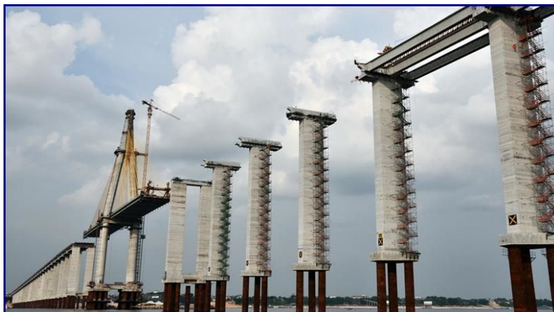
Figura 1: Construção da Ponte Estaiada sobre o Rio Negro. Fonte: Melo (Autora)
