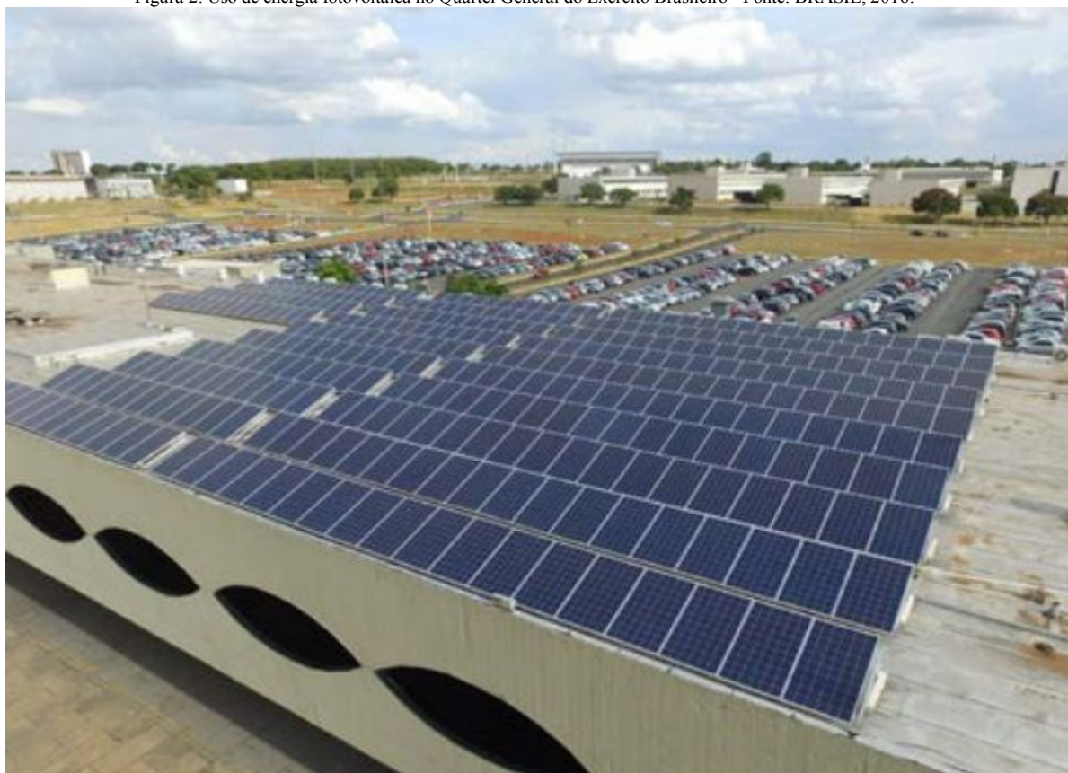
Figura 2. Uso de energia fotovoltaica no Quartel General do Exército Brasileiro - Fonte: BRASIL, 2016.
