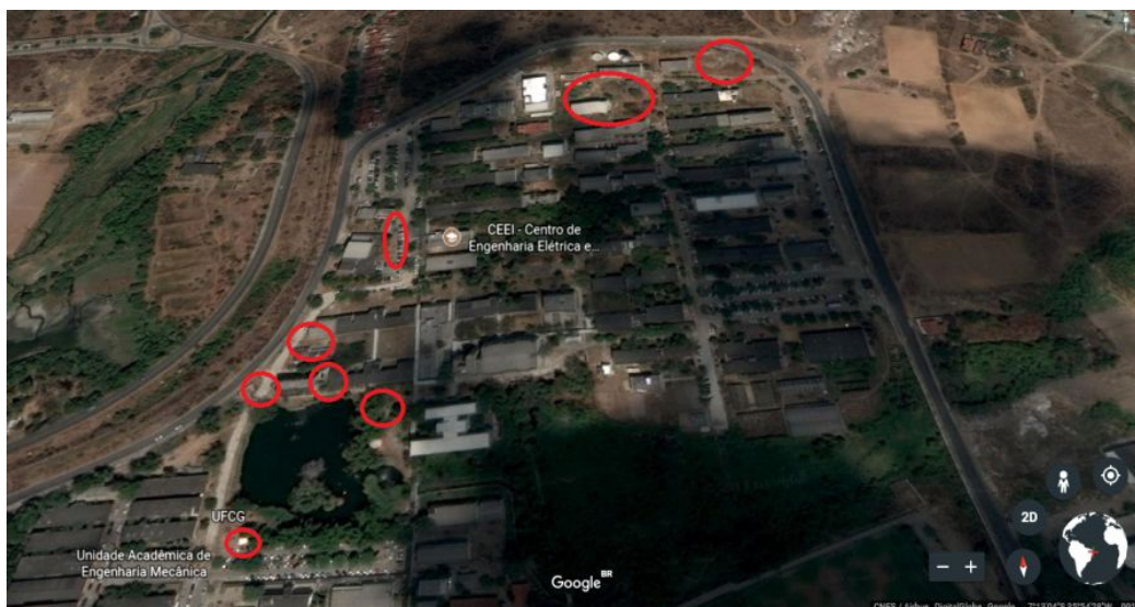
Figura1: Locais onde estão ocorrendo obras e reformas no campus I da UFCG e geração de RCDs. Fonte: Google Earth, 2017)
