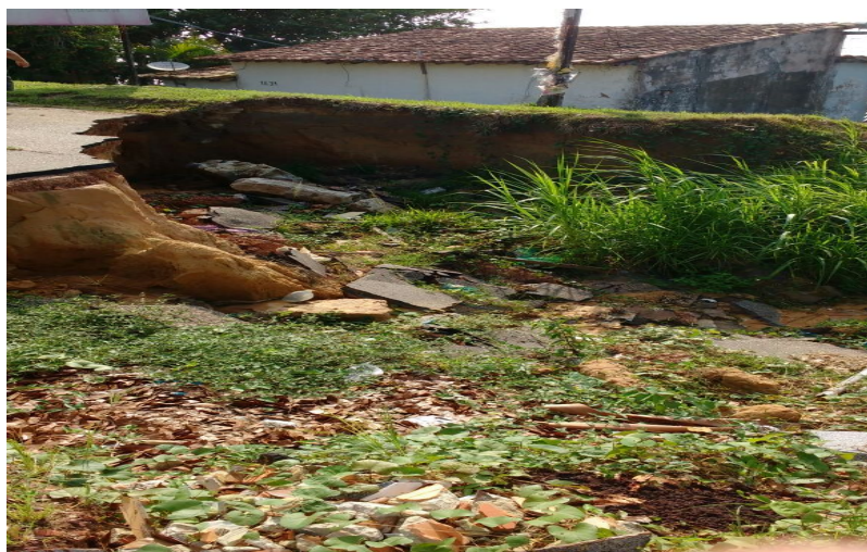
Figura 3: Erosão e a Falta de Saneamento observado no local Fonte: Autor, 2017.
