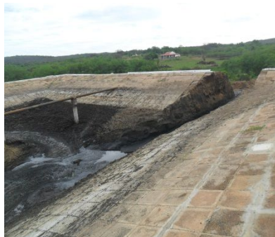
Figura 10, 11, 12: Lagoas passando por processo de limpeza. Fonte: Autores.
