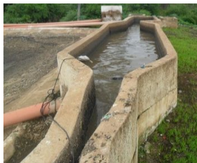
Figura 6: Chegada dos efluentes. Fonte: Autores. Figura 7: Caixa de areia. Fonte: Autores.
