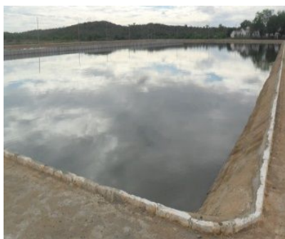
Figura 8: Lagoas Facultativas. Fonte: Autores. Figura 9: Lançamento. Fonte: Autores.
