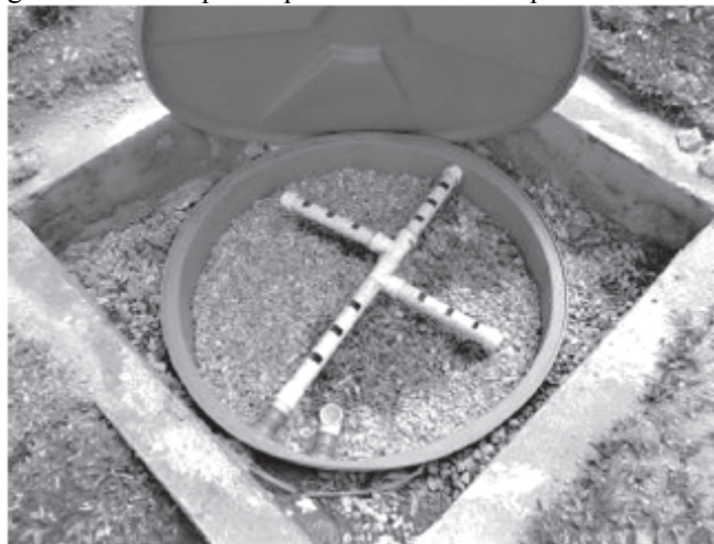
Figura 4: Filtro de brita. Fonte: Gonçalves et al. (2006)
