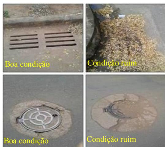
**Figura 2 – Condições dos equipamentos de drenagem. Fonte: Autores do trabalho.**
