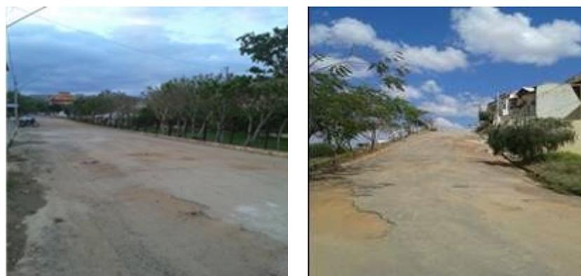
**Figura 3 – Erosão na pavimentação da Rua Acácias (à esquerda) e Rua Zulmira Vargas (à direita). Fonte: Autores do trabalho.**
