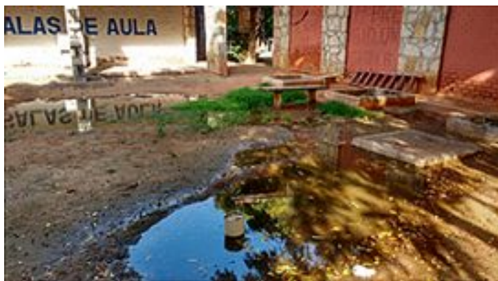
Figura 5: Sistema de Esgotamento Incorreto. UERN, Câmpus Mossoró-RN. Fonte: Autores da pesquisa, 2017.
