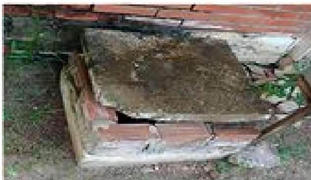
Figura 3: Caixa de Inspeção. UERN, Câmpus Mossoró-RN. Fonte: Autores da pesquisa, 2017.
