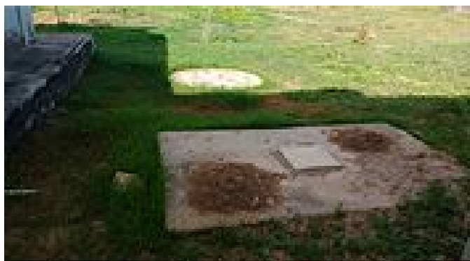
Figura 1: Sistema de Fossa Séptica-Sumidouro. UERN, Câmpus Mossoró-RN. Fonte: autores da pesquisa, 2017.
