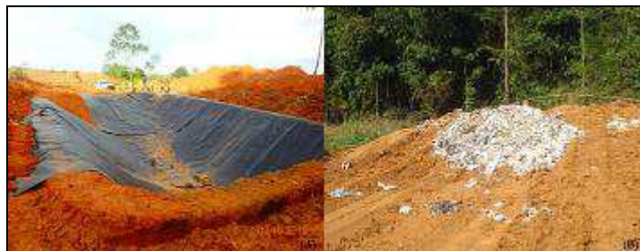
Figura 3: Célula de confinamento de Resíduos de Serviços de Saúde, no aterro controlado no município de Ji-Paraná. (A) Construção da célula no ano de 2013, (B) RSS dispostos na célula no ano de 2014. Fonte: OROZCO, M. M. D.
