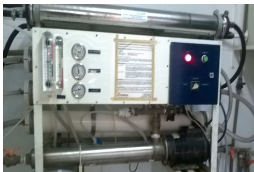
Figura 2: Aparelho de Osmose Reversa. Fonte: Autora do Trabalho.
