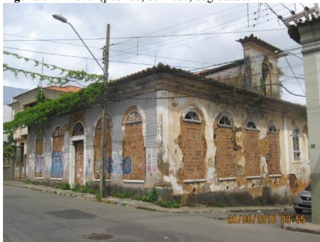
Figura 04: Imóvel (público) sem uso, degradado.
