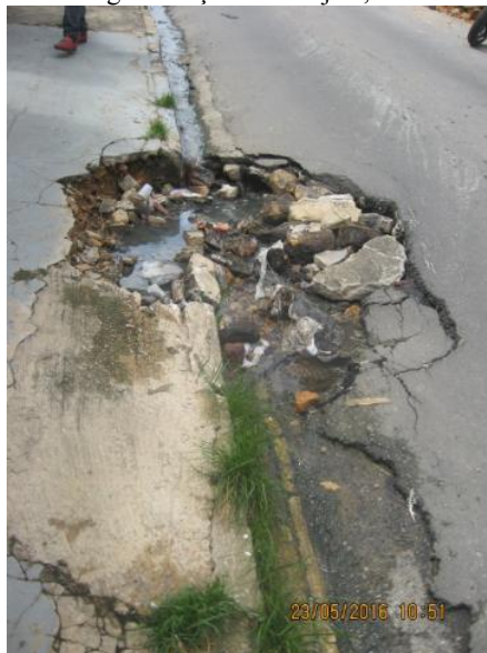
Figura 05 - Esgoto lançado na sarjeta, causando erosão.
