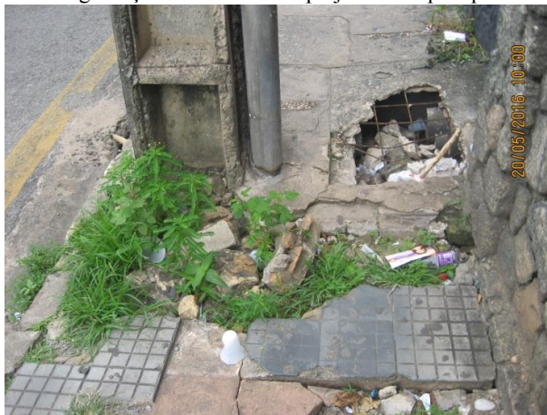
Figura 07: Segurança e acessibilidade prejudicados pela pavimentação.
