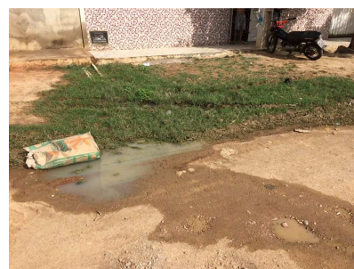
Figura 2: Esgoto a céu aberto, Caraúbas - RN. Fonte: Autor do Trabalho
