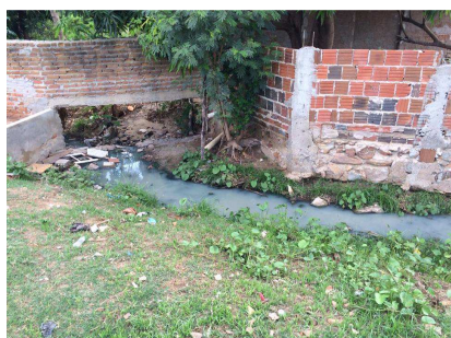
Figura 1: Esgoto a céu aberto, Caraúbas - RN. Fonte: Autor do Trabalho.
