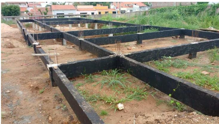
**Figura 04: Vigas baldrame impermeabilizadas com emulsão asfáltica. Fonte: Autor do trabalho.**
