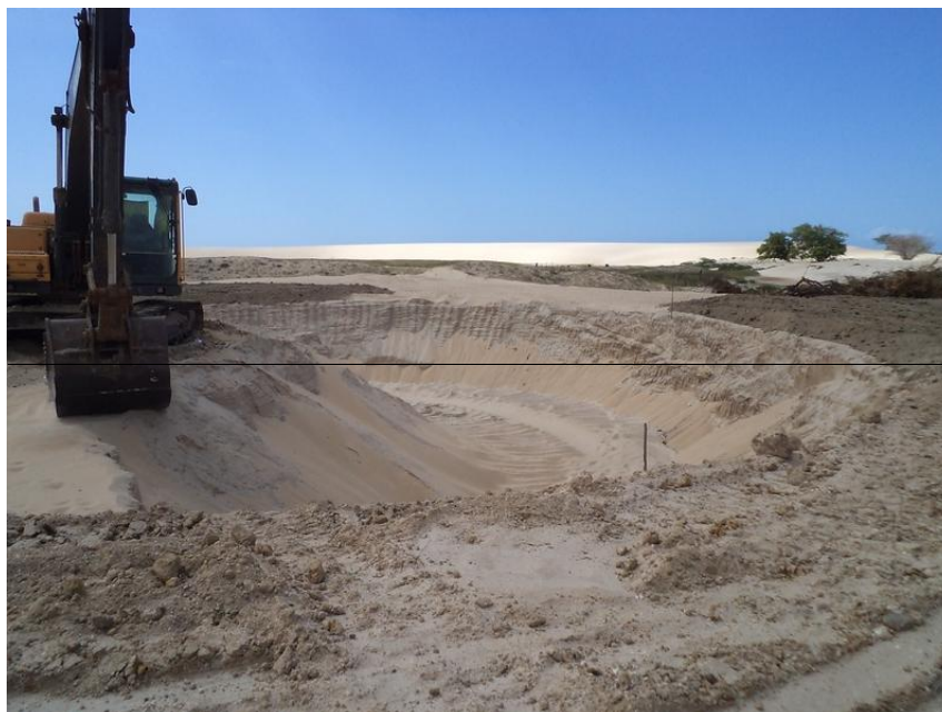
Figura 4: Escavações para realização da fundação de torres eólicas do Complexo Rei dos Ventos I, no município de Galinhos-RN. Fonte: BRASVENTOS (2013).
