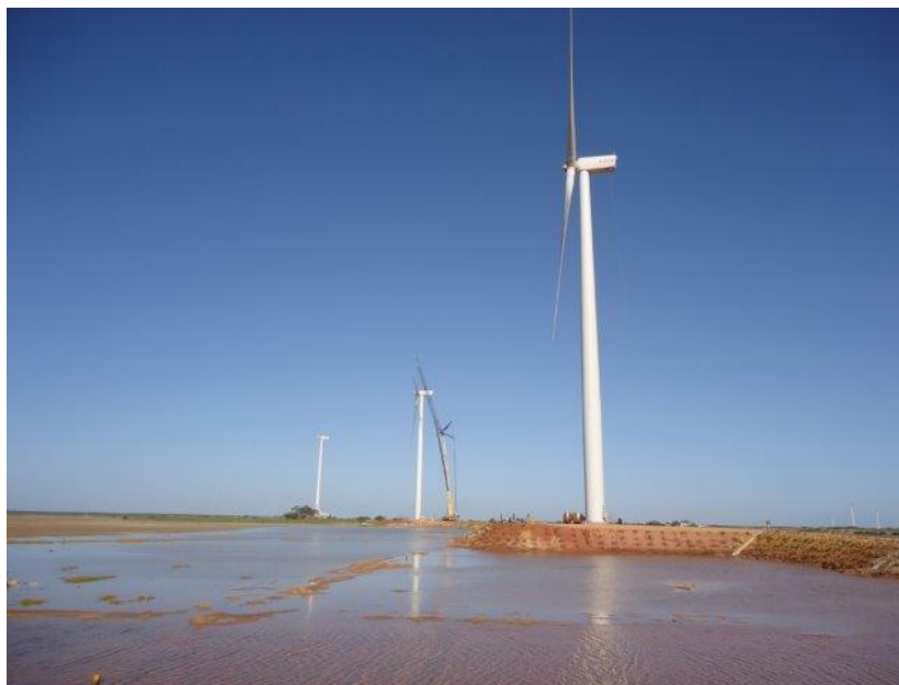
Figura 6: Torre eólica montada do Complexo Rei dos Ventos I, no município de Galinhos-RN. Fonte: BRASVENTOS (2013).
