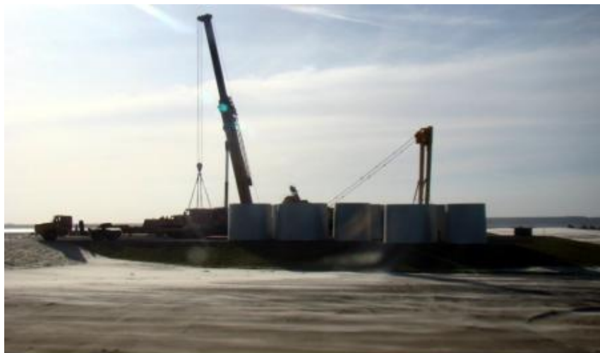
Figura 5: Peças de encaixe a serem içadas para montagem da torre eólica. Fonte: FEAM (2013).
