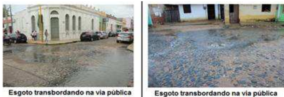
Figura 3 – Esgoto a céu aberto em via pública. Fonte: CAOMACE.
