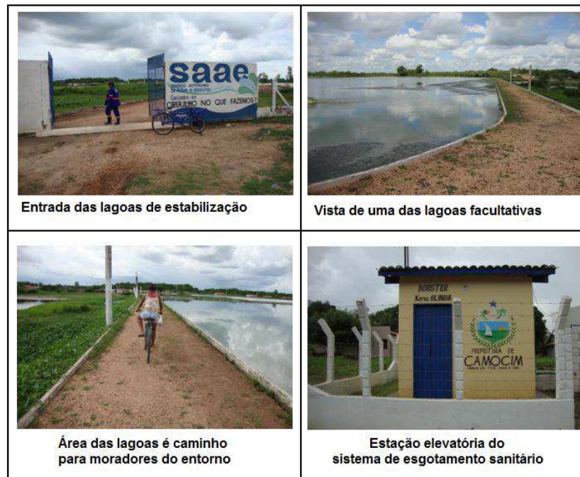
Figura 2 – Estação de tratamento de esgoto de Camocim.
