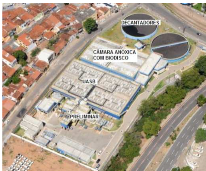
Figura 1: Vista aérea da ETE do Baldo. Fonte: FUNCERN (2013).
