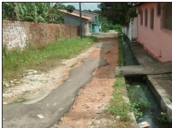
Figura 1. Rua do bairro do Taíra 1 com infraestrutura de drenagem e pavimentação deficiente. Fonte: Autor do trabalho.
