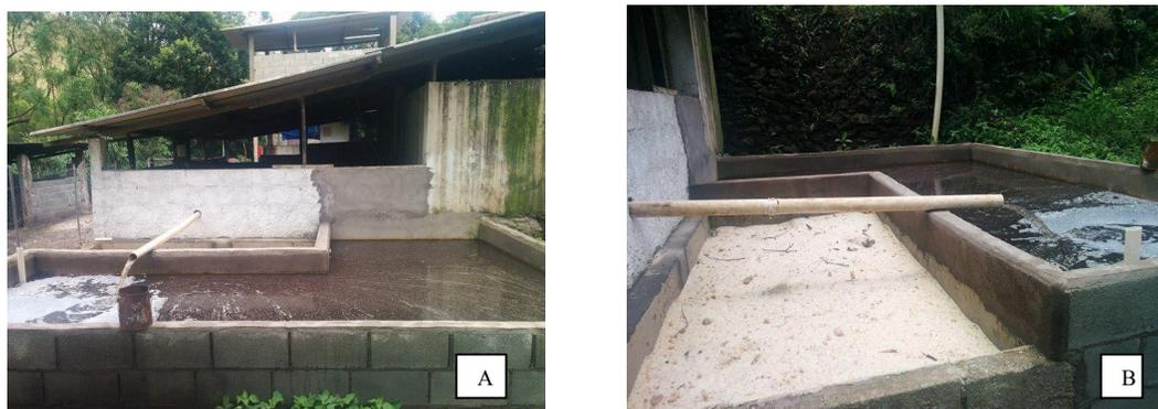
Figura 4: Instalações do tanque de decantação (A) e Instalações do filtro de areia (B). Fonte: Autor do trabalho.
