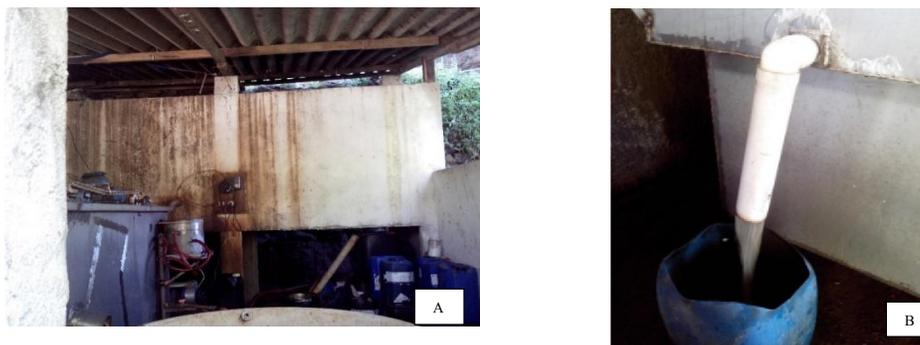
Figura 1: Tanque de agitação: Coagulação (A) e Efluente tratado (B). Fonte: Autor do trabalho.
