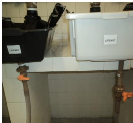
Figura 4: Montagem dos Bags. Fonte: GPTA.
