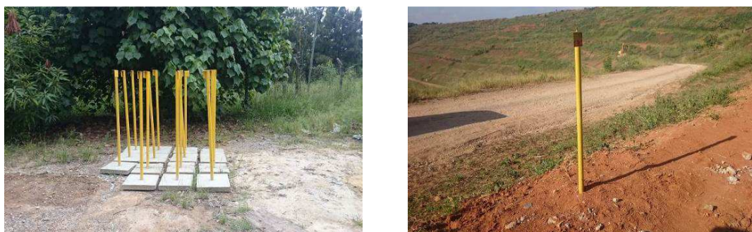
Figura 4 – Medidores de recalques
