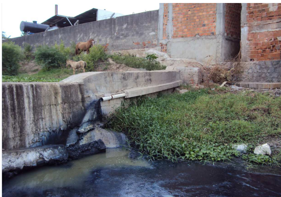
Figura 2: Lançamento de efluente sem tratamento no rio Capibaribe por uma lavanderia de jeans em Toritama-PE. Fonte: autores (2014)
