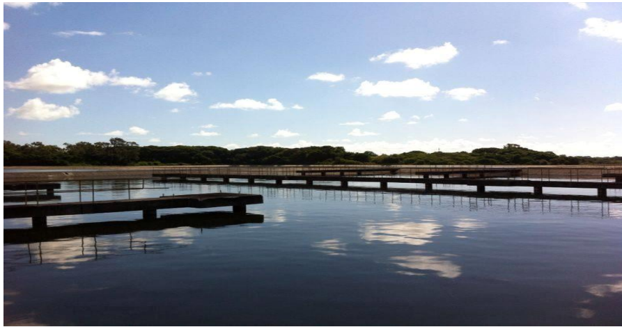
Figura 1: Lagoa Anaeróbia, módulo III da ETE de João Pessoa-PB. Fonte: Autor do Trabalho.
