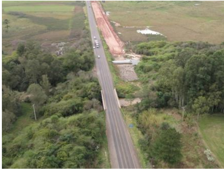
Figura 1: Visualização geral da área de APP interceptada pela rodovia.
